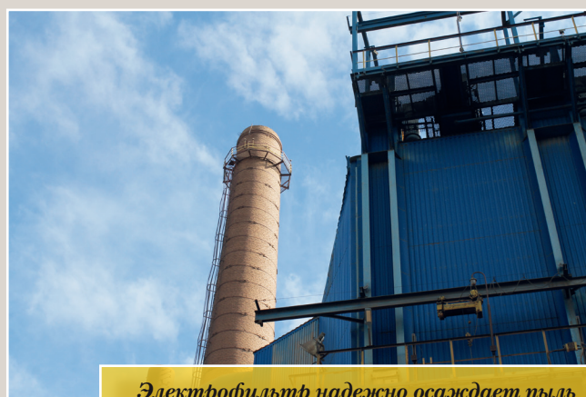
Электрофильтр надежно осаждаёт пыль
